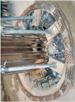
Figura 6.2. Preparación para hormigonado en base de pilares mixtos (Torre de Cristal, Madrid)
