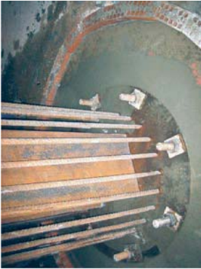
Figura 6.3. Hormigón Autocompactante de 100 MPa ejecutado (Torre de Cristal, Madrid)
